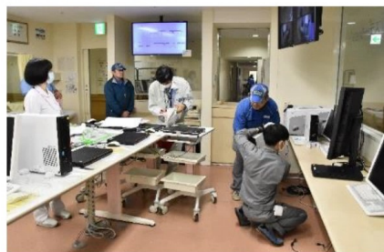
新システムの設置作業
