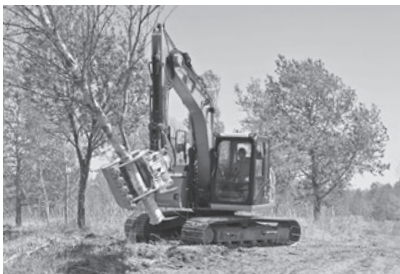
民間リース器材を用いた支障木の伐採
