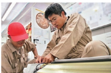
エアコンの整備作業を行う施設班員
