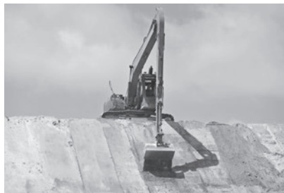
油圧ショベルによる停弾堤整備
