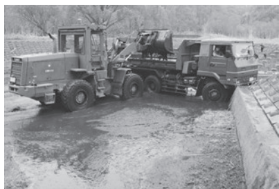
バケットローダによる沈砂池の泥上げ
