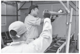
拠点内工事をする施設隊員
