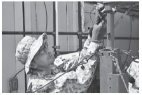
アンテナを建柱する通信陸曹
