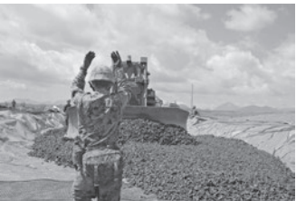
総合戦闘射場の路盤強化
