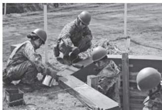
浸透柵の整備
