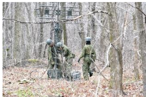
アンテナ建柱
