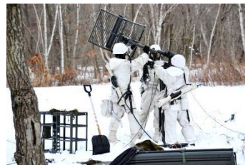
搬送班のアンテナ建柱
