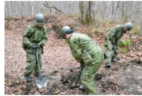
道路横断埋設!
