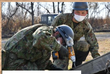
レンジャー訓練場整備
