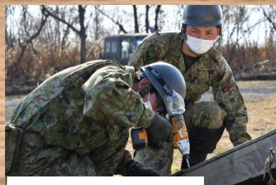
レンジャー訓練場整備
