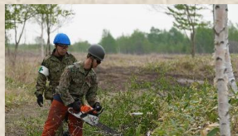
支障木の伐採
