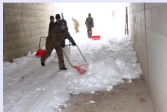
▲ 手作業による高架下への雪の搬送
