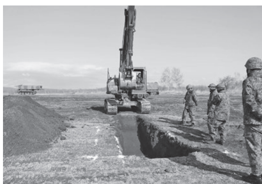
陣地構築のための掘開（第4中隊）
