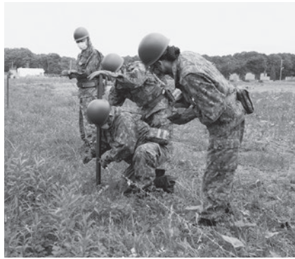
柵型鉄条網の構築
