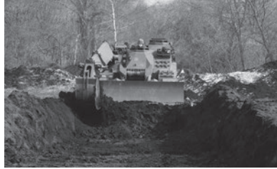
EVによる対戦車壕の構築
