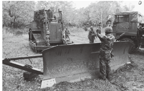
ドーザーへの排土板の取り付け
