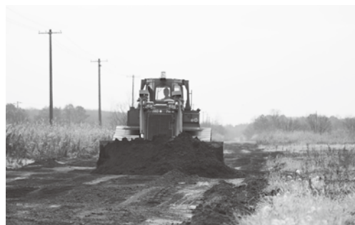
東千歳地区装軌道整備
