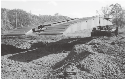
戦車橋の架設
