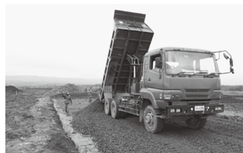
第1戦車射場路盤強化
