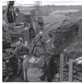
訓練施設整備
