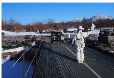
架設後の試験走行
