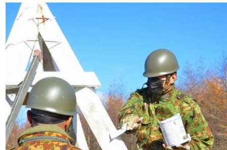
三角觇標の塗装
