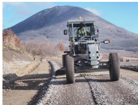
装輪車道整備
