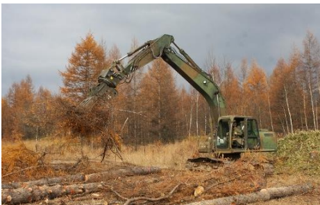
支障木の撤去
