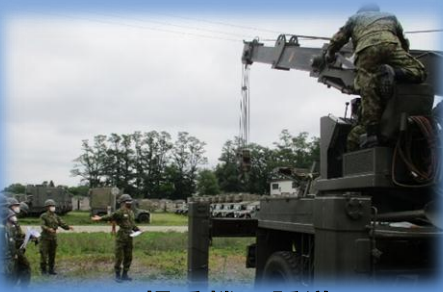
揚重機の誘導 (第5後方支援隊)
