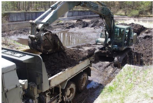
沈砂池の泥除去
