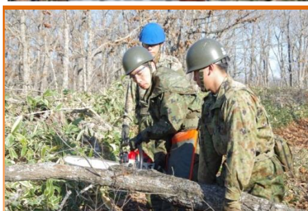
支障木の伐採
