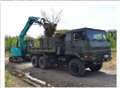
フェラーバンチャによる積載作業
