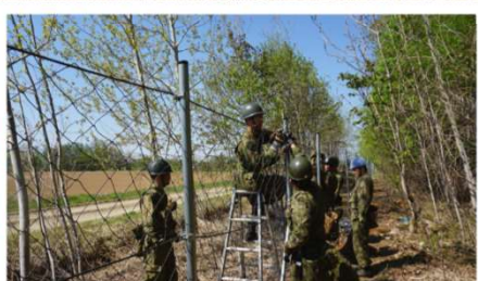
害獣ネットを設置（美幌訓練場）
