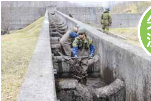
ダムの堆積物の除去
