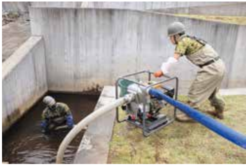
機械による排水
