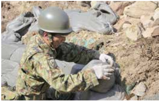
土のうを積み上げる3中隊員
