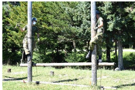
連結 鉄線結びや十字結びを使い木材と木材を連結していきます。これで高所作業もできるようになります。
