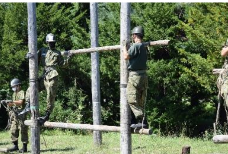
連結 鉄線結びや十字結びを使い木材と木材を連結していきます。これで高所作業もできるようになります。
