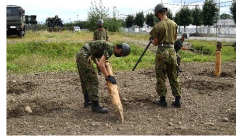
植杭 打ち方にも色々な種類があります。固定打ち、挿み打ち・振り打ち等 木にささくれないか確認
