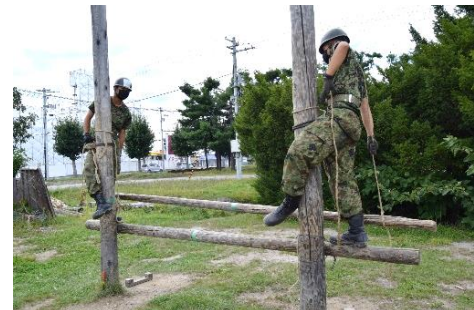
連結 鉄線結びや十字結びを使い木材と木材を連結していきます。これで高所作業もできるようになります。
