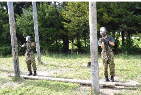
連結 鉄線結びや十字結びを使い木材と木材を連結していきます。これで高所作業もできるようになります。
