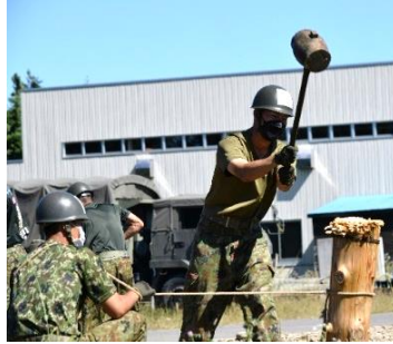
植杭 打ち方にも色々な種類があります。固定打ち、挿み打ち・振り打ち等 木にささくれないか確認
