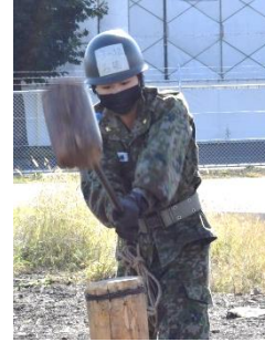
植杭 打ち方にも色々な種類があります。固定打ち、挿み打ち・振り打ち等 木にささくれないか確認
