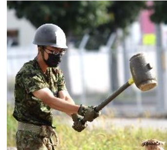
植杭 打ち方にも色々な種類があります。固定打ち、挿み打ち・振り打ち等 木にささくれないか確認
