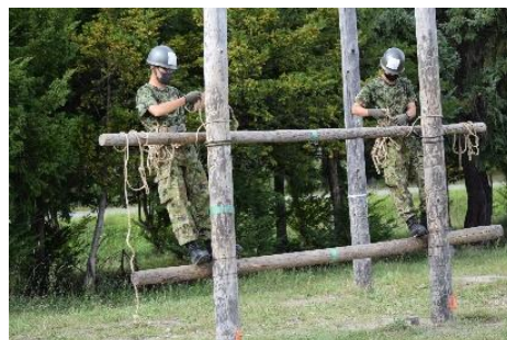
連結 鉄線結びや十字結びを使い木材と木材を連結していきます。これで高所作業もできるようになります。
