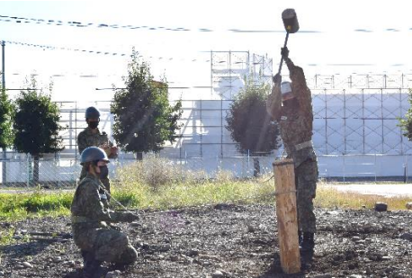
植杭 打ち方にも色々な種類があります。固定打ち、挿み打ち・振り打ち等 木にささくれないか確認
