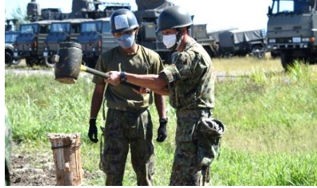
植杭 打ち方にも色々な種類があります。固定打ち、挿み打ち・振り打ち等 木にささくれないか確認
