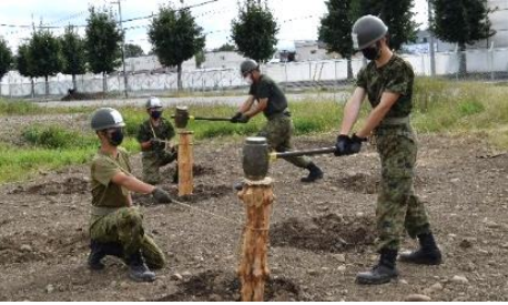
植杭 打ち方にも色々な種類があります。固定打ち、挿み打ち・振り打ち等 木にささくれないか確認
