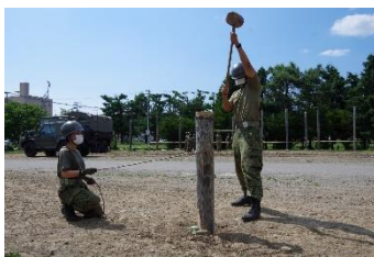
施設基礎作業「植杭」かけやで力強く杭を打ち込んでいます。気合を合わせて作業中！
