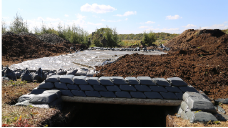
▲ 掩盖材を使用し強靱な指揮所を構築
