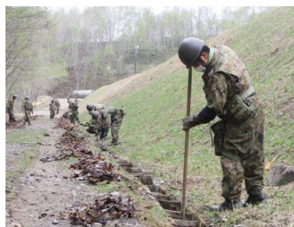
▲側溝の整備(真駒内射場地区)
