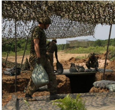
▲土嚢を積み上げ強固に築城
