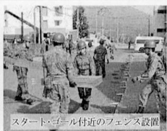
スタート・ゴール付近のフェンス設置
