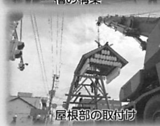
クレーン作業による槽の構築
