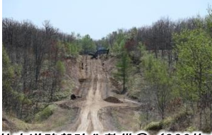
装軌車道路盤強化整備①（399施中）
