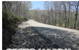
装軌道整備（400施中）
