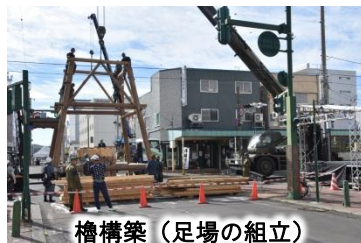
櫓構築（足場の組立）
