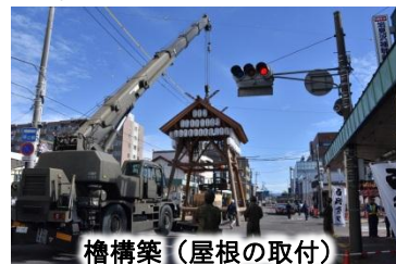
櫓構築（屋根の取付）
