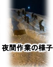
大型滑り台製作の様子
