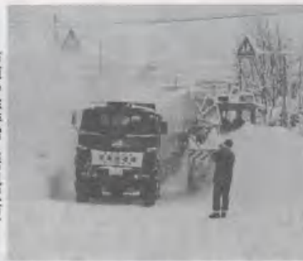
市道の除排雪（岩見沢市）
