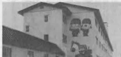
生活隊舎完成
