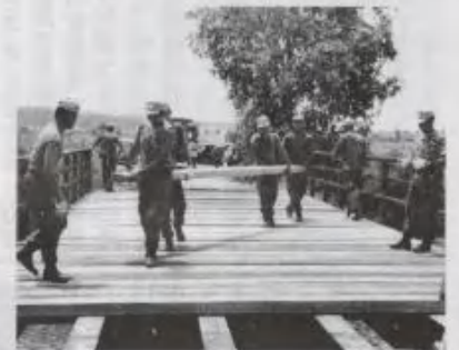
完成間近の橋の補修
