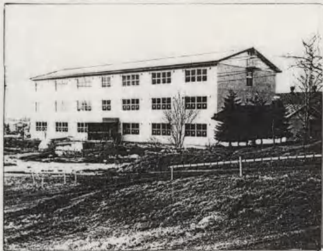
隊員宿舎新築工事進む
