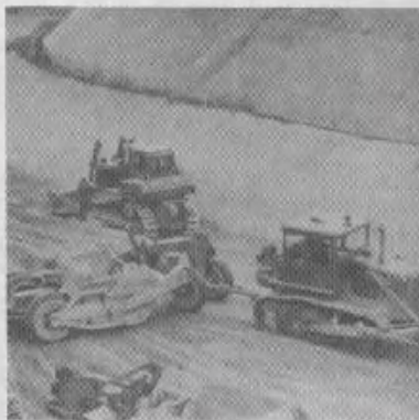
総動員の建設機械作業
