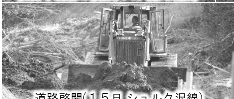
道路啓開(15日 シュルク沢線)
