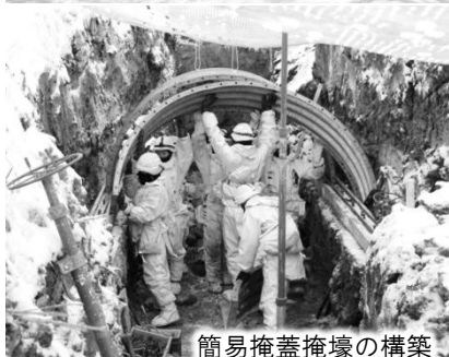
簡易掩蓋掩壕の構築
