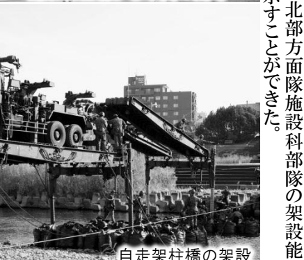
自走架柱橋の架設
