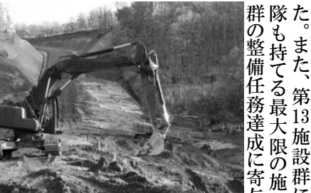
装軌車道法面改修整備(北大演・399施中)
