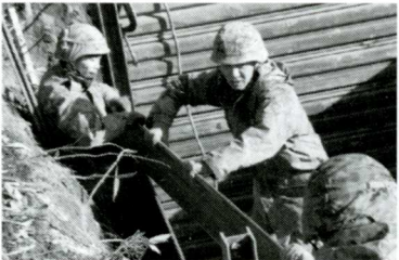
排水設備の整備
