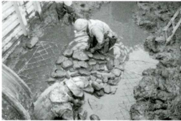
薄水が張る中での排水整備
