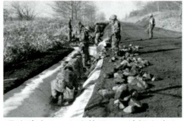
吸出防水シートを使用して洗掘を防止
