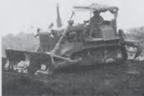
ドーザによる掘開
