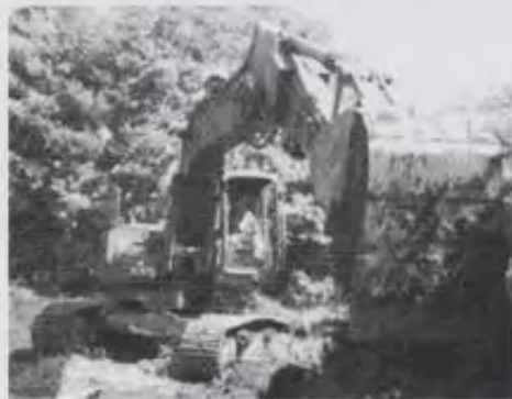
油圧ショベルによる掘開
