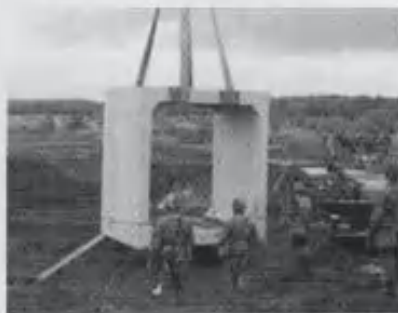
ボックスカルバートの設置
