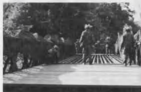
パネル橋構築の様子
