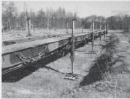
架柱橋完成の様子（横から）
