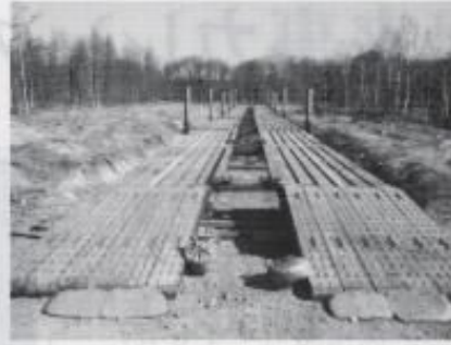
架柱橋完成の様子（正面より）
