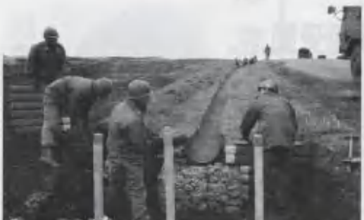
竹の橋側溝整備
