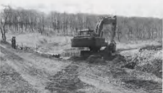
ハスッカブ道拡幅工事後
