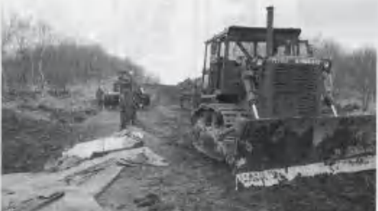
ハスッカブ道拡幅工事前
