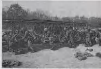
パネル橋押し出し作業
