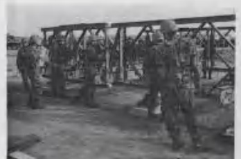
パネル橋架設
