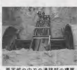
悪天候の中での通路部の構築
