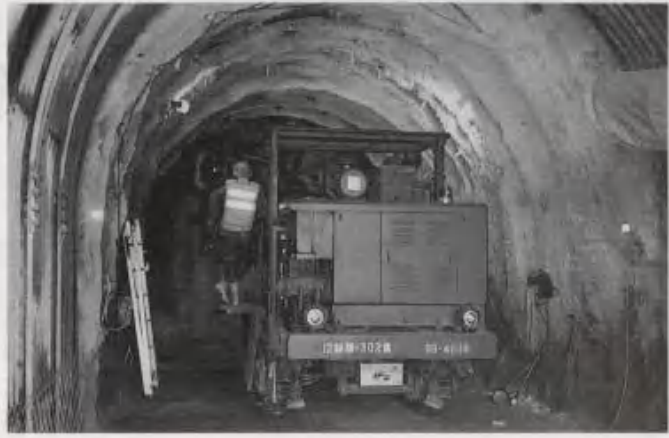
坑道中隊掘削作業
