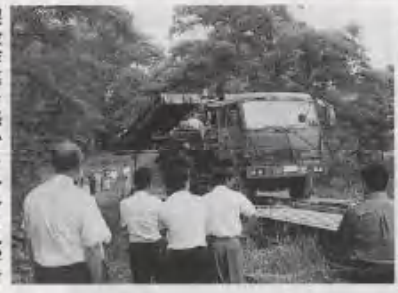
架設作業を熱心に見入る見学者
