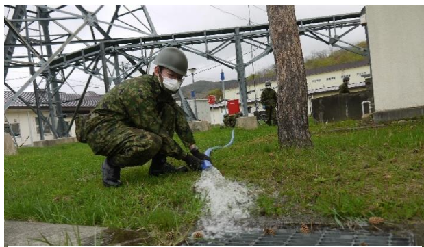
マンホール内の水抜き (第314基地通信中隊)
