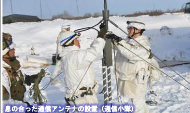
息の合った通信アンテナの設置 (通信小隊)
