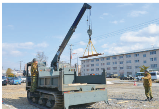
揚重機操作訓練
